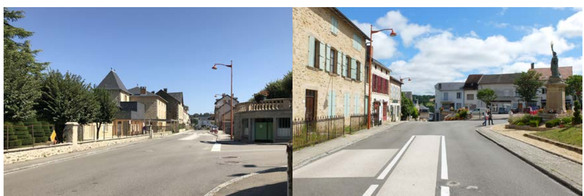
La façade formée par le parc public et la demeure J. Limousin fait écho à la terrasse publique arborée en contre-haut de la rue.
