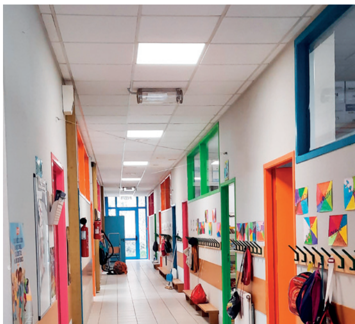
Travaux de peinture à l'école primaire, les portes ont retrouvé une couleur pimpante
