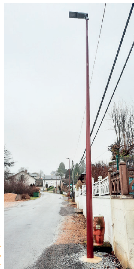
Pose de candélabres pour l'éclairage public, route de moussanas
