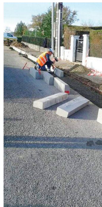
Rénovation des trottoirs du Peyrassaud
