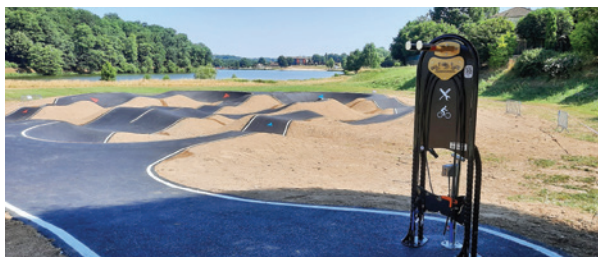
Travaux du pumptrack en juin 2025
