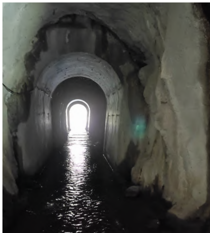
Vue depuis la chambre des vannes.
