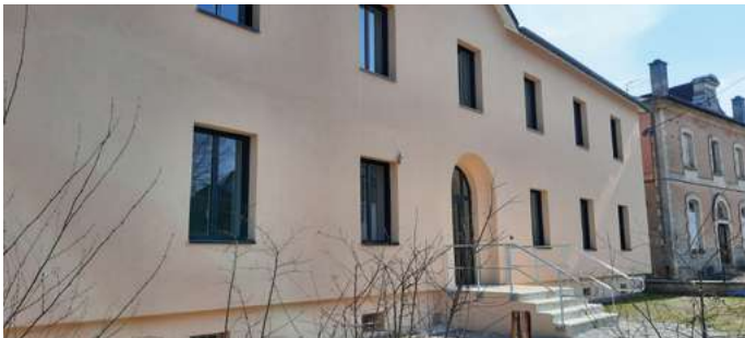
Avancée des travaux maison des associations
