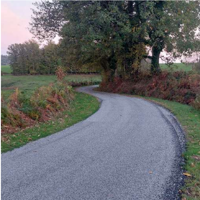
Réfection des routes avec pose de point à temps : route de Besuniéras vers Sussac, route de Villetelle, au Sus en direction du Maroc
