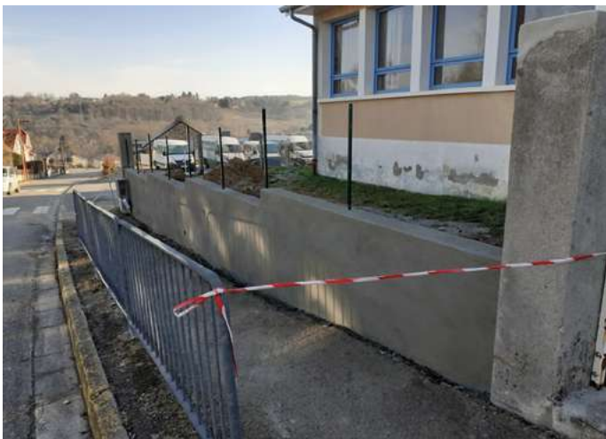
Démolition et reconstruction du mur de la garderie
