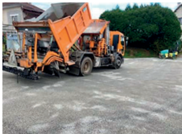
Réfection du parking des écoles
